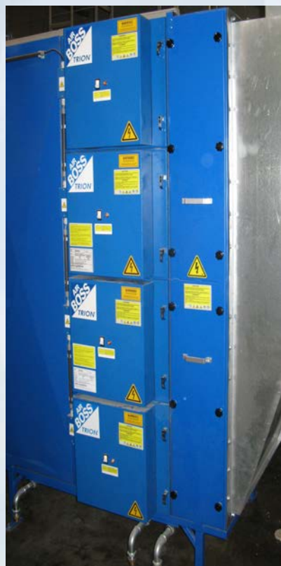
Extra voorfiltersectie 2 x 50 mm inox filters
